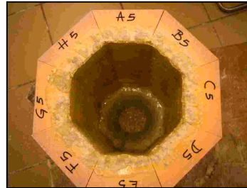
Revêtement après corrosion par un verre
