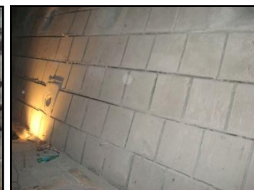
Suivi des travaux dans une centrale thermique
