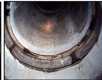
Inspection après séchage de compensateurs en raffinerie
