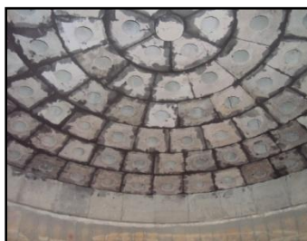
Suivi montage d'une voûte de fluidisation
